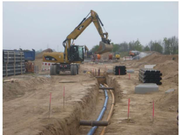
Verlegung von Trinkwasserversorgungsleitung in Guss im H 17; Quelle: Stadtwerke Rodgau
