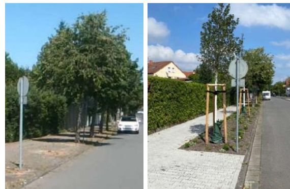
Umgestaltung der Opelstraße in Dudenhofen: Teilentsiegelung und Neubepflanzung des Gehwegs (Quelle: Stadt Rodgau, Umwelt- und Klimaschutzbericht 2020)
