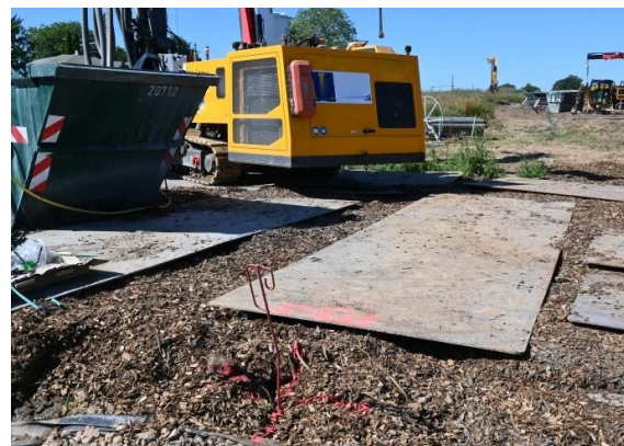
Auslegung von Lastverteilplatten auf einer Baustelle, um Bodenverdichtung vorzubeugen (Quelle: Ingenieurbüro Schnittstelle Boden GmbH)
