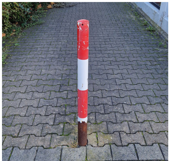
Abb. 13: Verkehrspoller im Bereich der Unteren Marktstraße
