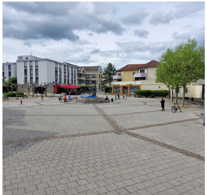
Abb. 6: Wichtige Sichtbeziehung von der Unteren Marktstraße
