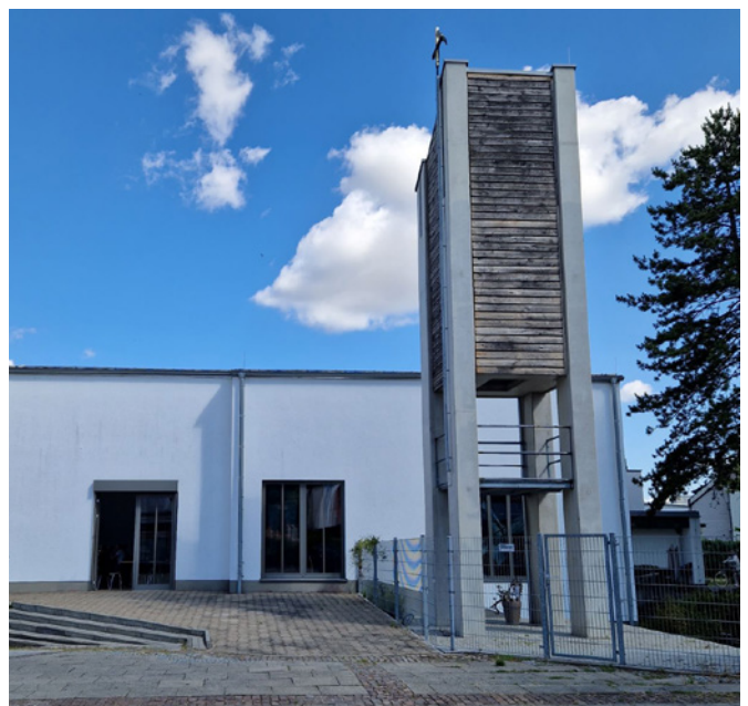
Abb. 8: Glockenturm und Gemeindehaus
